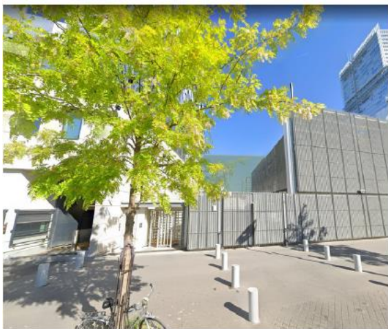
Photo 1 : Vue rue du Bastion
