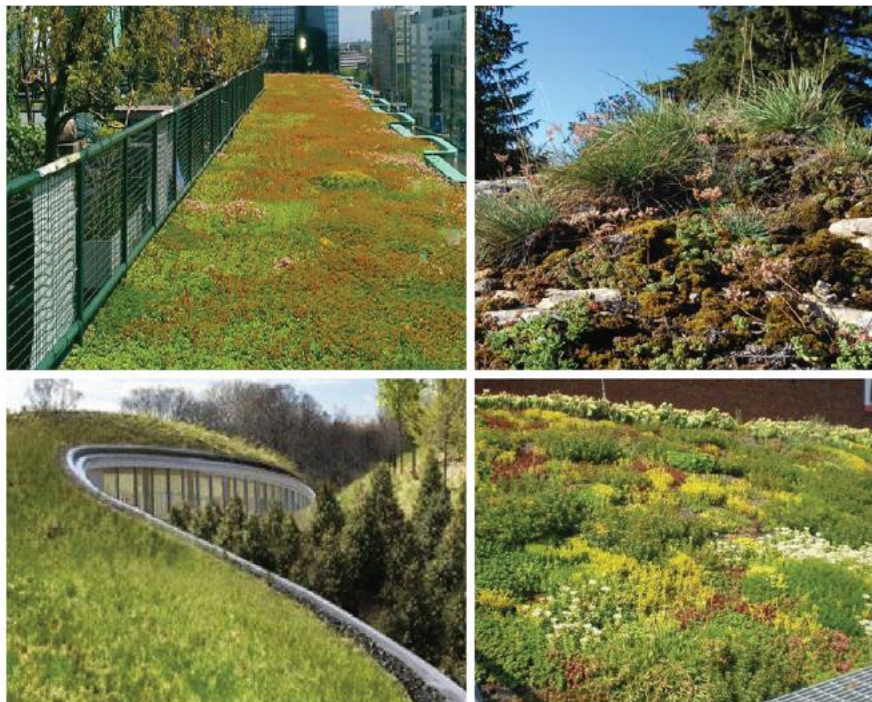
Figure 40 : Dôme végétalisé (source : DTACC)
