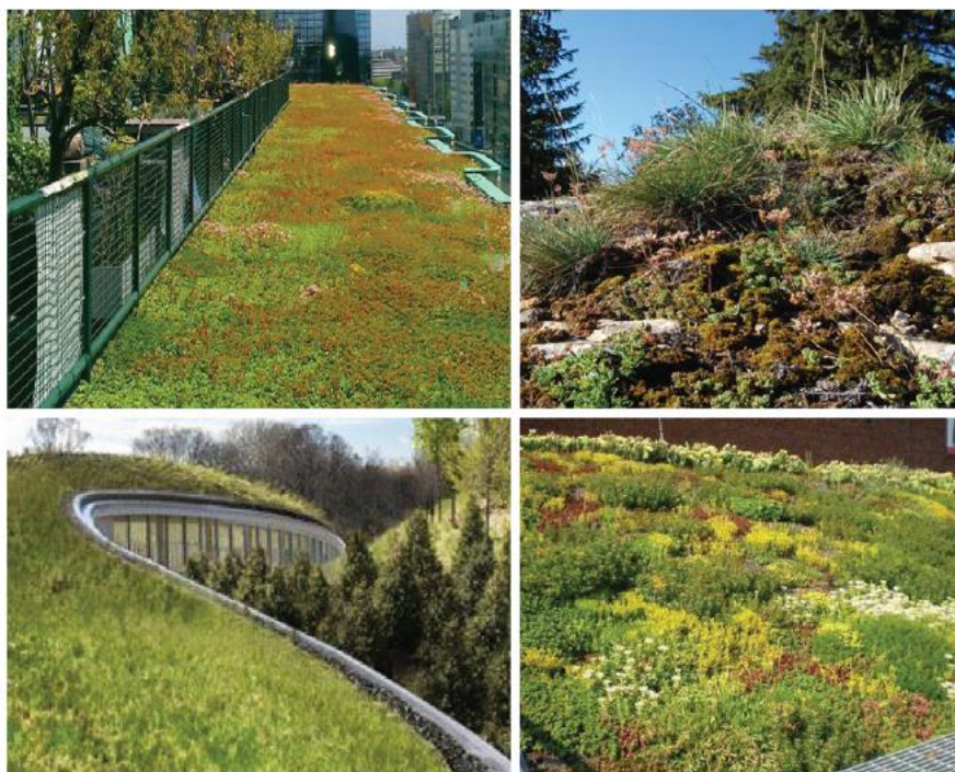
Figure 177 : Dôme végétalisé (source : DTACC)
